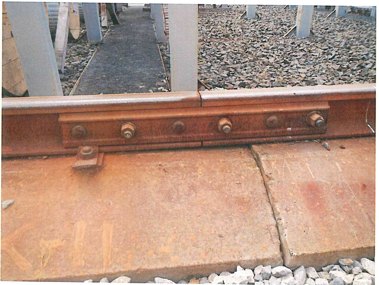
фото 4. Ослаблено болтовое соединение стыковых скреплений, болты не имеют смазки.
